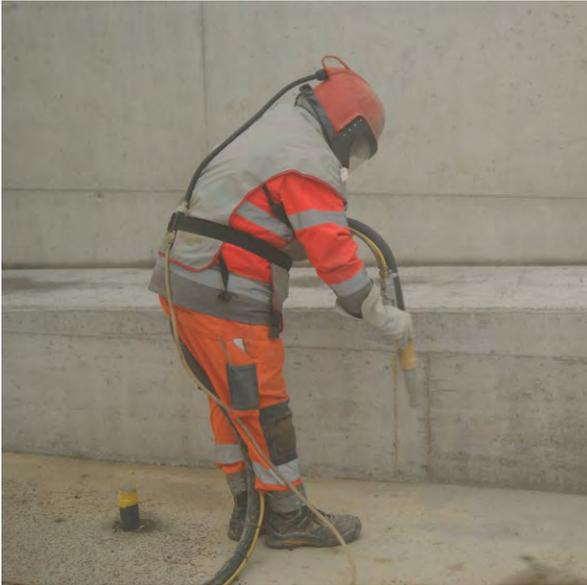
Sandstrahlen ist ein Verfahren, um die oberste Schicht des Untergrundes aufzurauben oder abzutragen. Das mit Druckluft getriebene Strahlmittel schlägt mit hoher Energie auf die Oberfläche des Untergrundes auf und löst – je nach gewähltem Strahlmittel und Untergrundbeschaffenheit – eine gewisse Schichtdicke ab. Beim normalen Sandstrahlen bleibt der Untergrund trocken.
