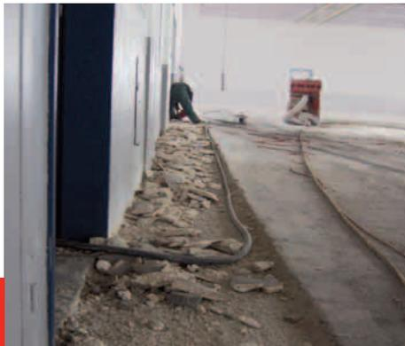
**Fräsen von verschiedenen Bodenbelägen bis Tiefe 16 cm, staubarm, Dieselgeräte ausgerüstet mit Russpartikelfilter**
