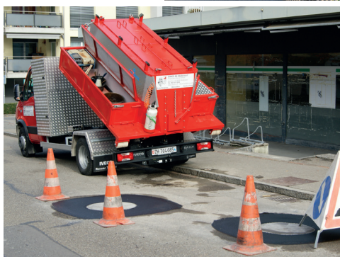
Fahrzeug mit Thermosilo für Asphalt
