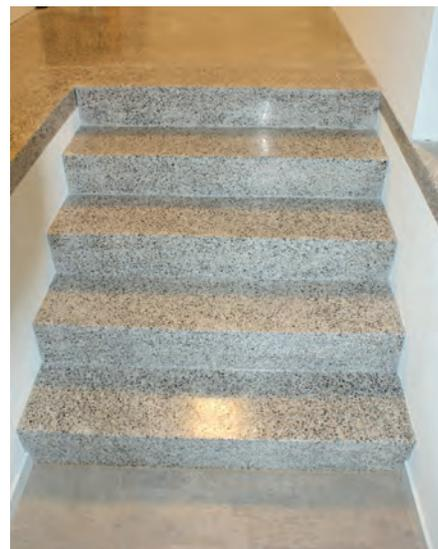
Geschliffener Hartbetonbelag weiss eingefärbt.
